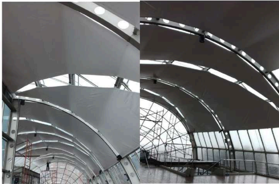
Ilustración 5. Membrana Arquitectónica – Sede Fundadores / Cúpula.
