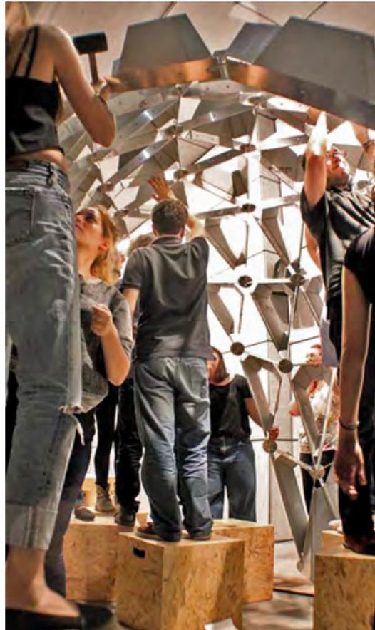
Figura 5. Montaje de las piezas. Estrategias para estructuras en bóvedas metálicas. / Fuente: Pablo Baquero (2014).
